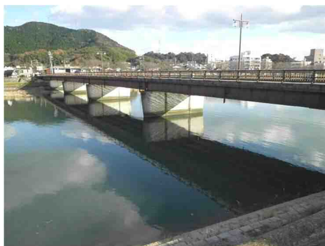
最も長い橋梁: 千歳橋(鋼桁橋 橋長142.8m 1988年完成)
