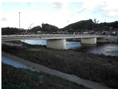
特殊な橋梁: 三島橋(鋼プレビーム合成桁橋 橋長93.5m 2012年完成)
