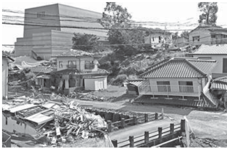
▲平成 28 年 4 月に発生した熊本地震被災地の状況（益城町）
