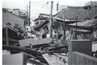
▲阪神大震災では死亡原因の約9割が建物の倒壊や家具の転倒によるものでした。命を守るため、住まいの耐震化を進めましょう。
