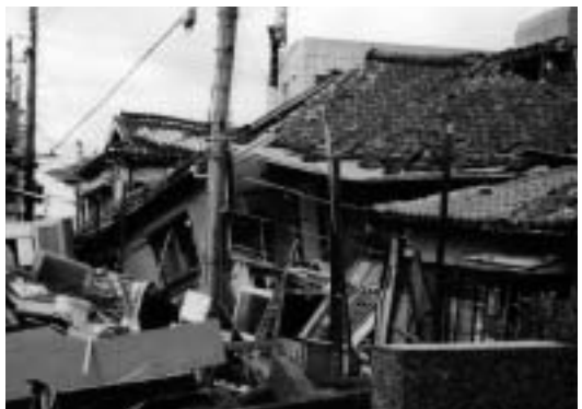
阪神淡路大震災で破壊された家
