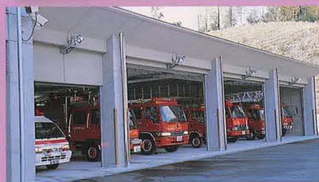
新消防庁舎車庫
