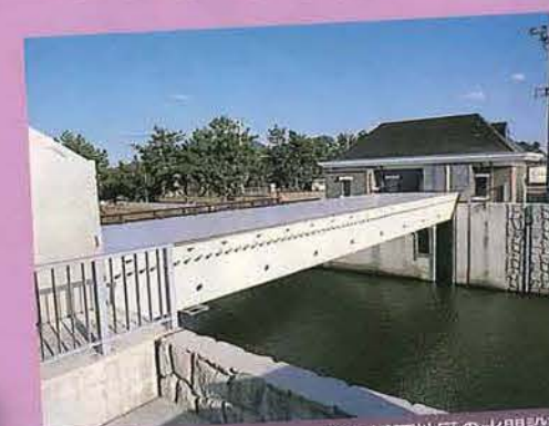
虹ヶ浜西地区の水門設置
