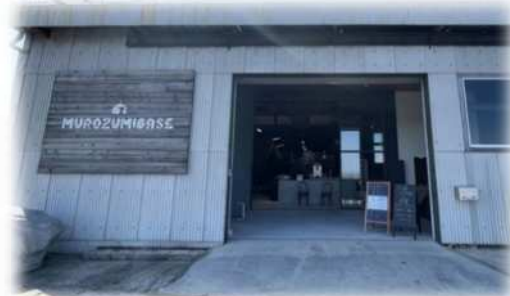
室積 BASE 内に設置
