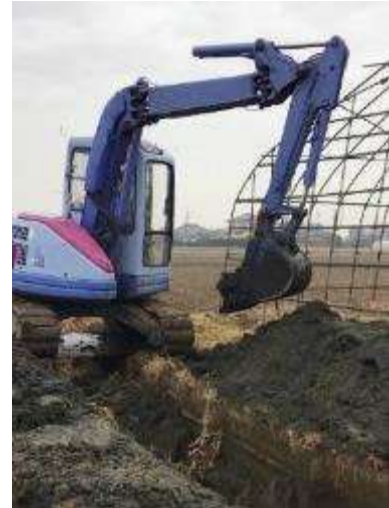
重機による水路の泥上げ (千葉県 Web サイトより)
