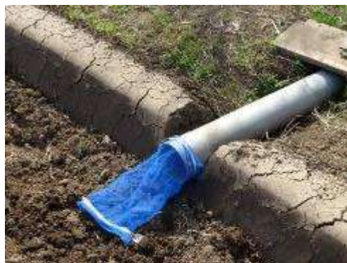
取水口への網の設置
