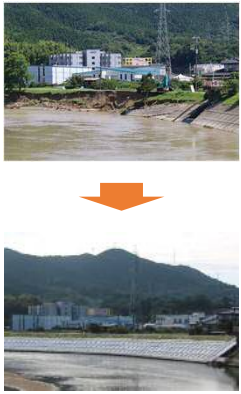
護岸工事が完了した島田川(木の下橋付近)
