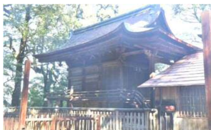
石城神社本殿保存修理事業
