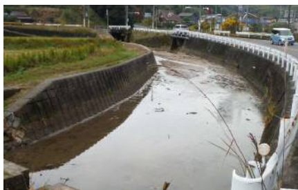
河川水路浚渫事業
