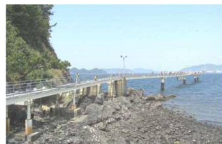
フィッシングパーク施設整備工事
