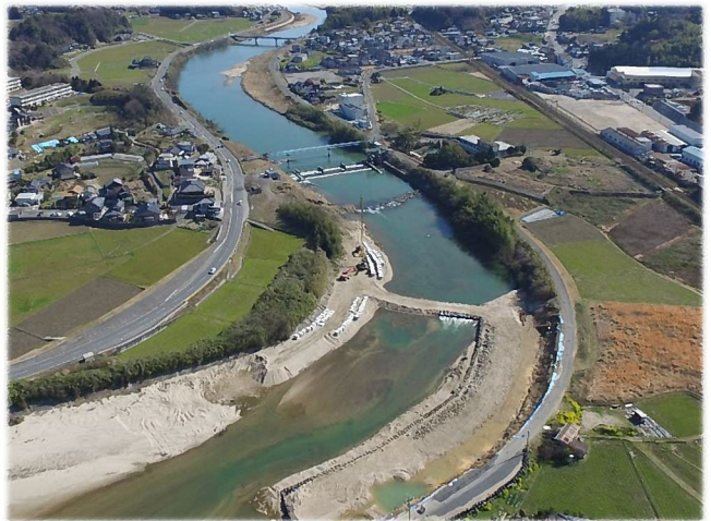
島田川護岸崩壊の復旧工事の状況（島田地区）
