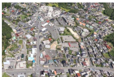
岩田駅周辺都市施設整備事業
