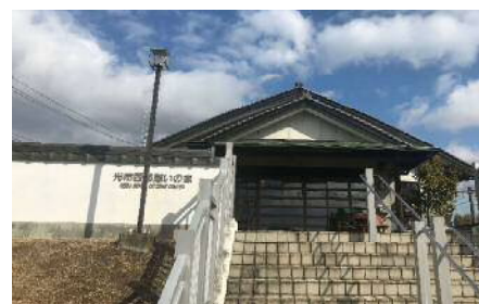
憩いの家トイレ改修工事
