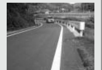
道路整備事業 (黒杭1号線舗装整備)
