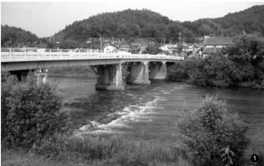
架け替えが緊急の課題となっている三島橋 「みしま水辺の会」メンバーによる現地視察 メンバーは、河川改修案をグループに分かれて、さらに検討を加えました。
