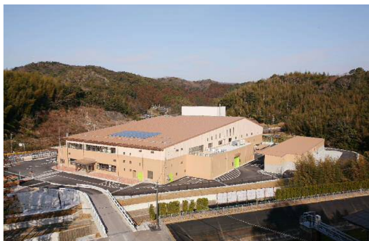
周南東部環境施設組合 リサイクルセンター「エコぱーく」
