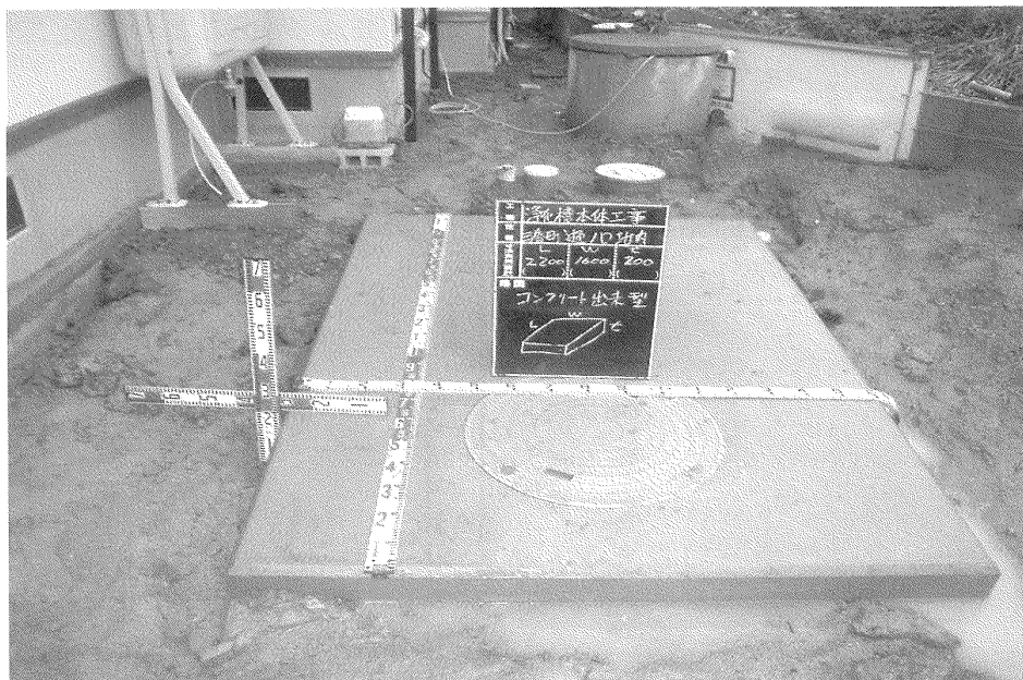
＜上部コンクリートの仕上げ例＞
