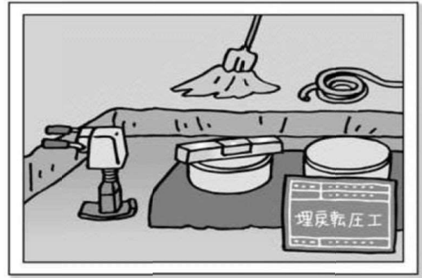
写真(埋戻し転圧状況)
