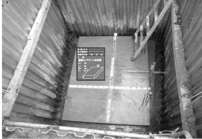
写真(基礎コンクリート仕上り状況)
