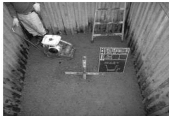
写真(基礎碎石仕上り状況 例2)
