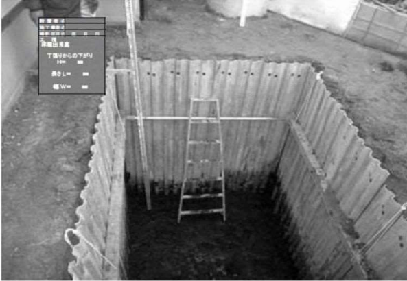
写真(床付け完了状況)
