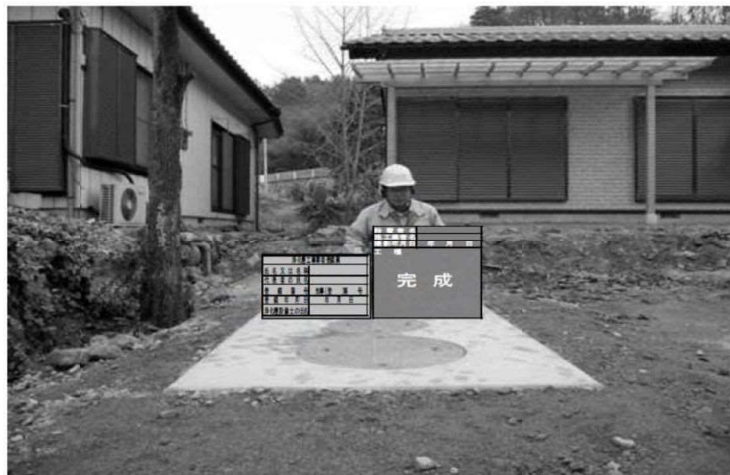
写真(完成状況)
