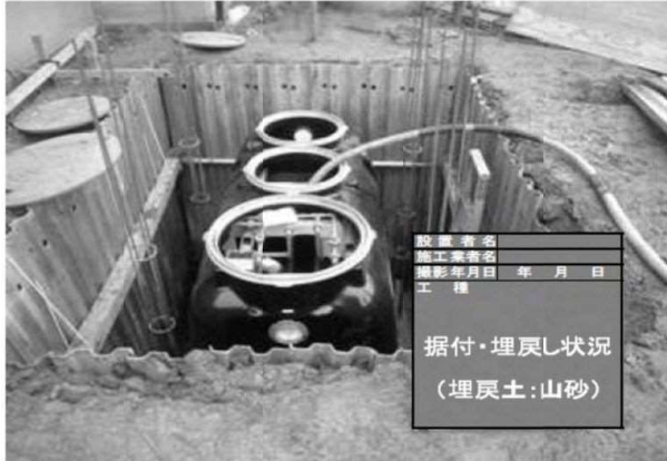
写真(埋戻し状況)
