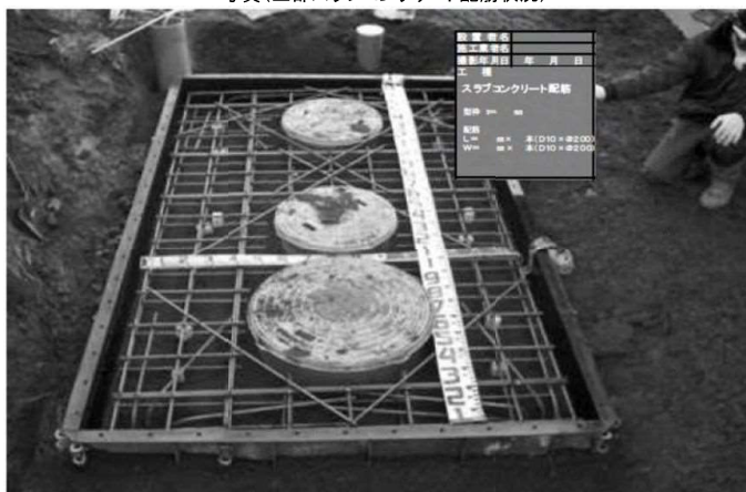
写真(上部スラブコンクリート配筋状況)
