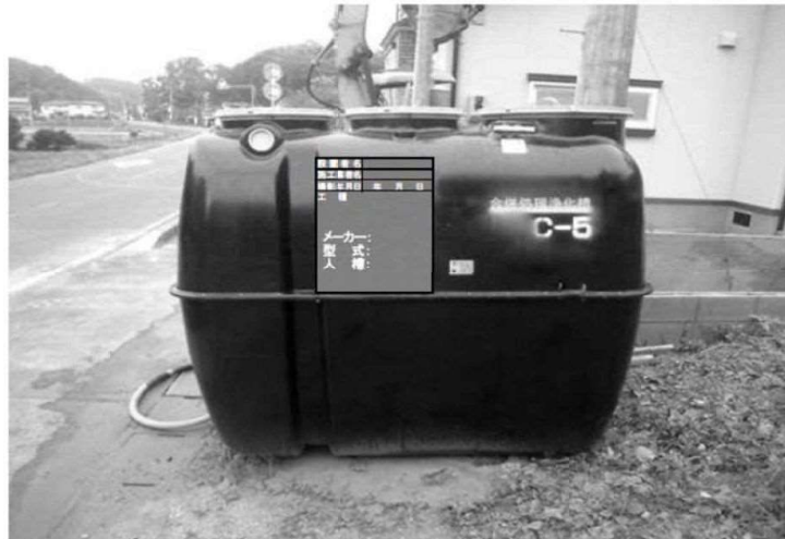
写真(浄化槽本体搬入の写真)
