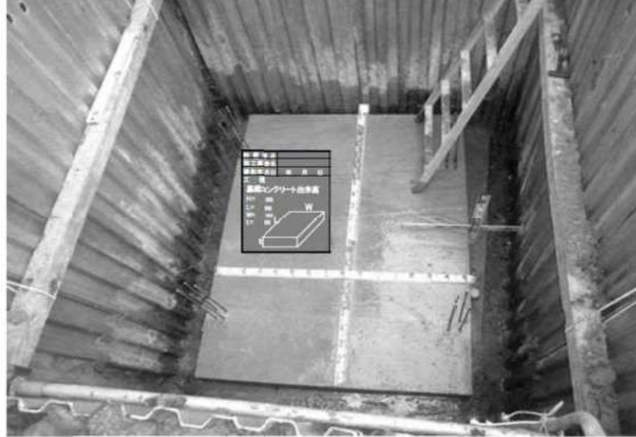
写真(基礎コンクリート仕上り状況)
