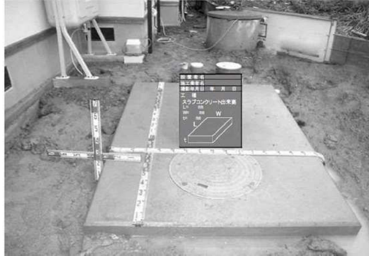
写真(上部スラブコンクリート仕上り状況)
