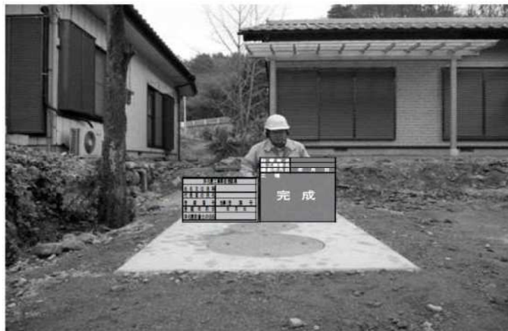
写真(完成状況)
