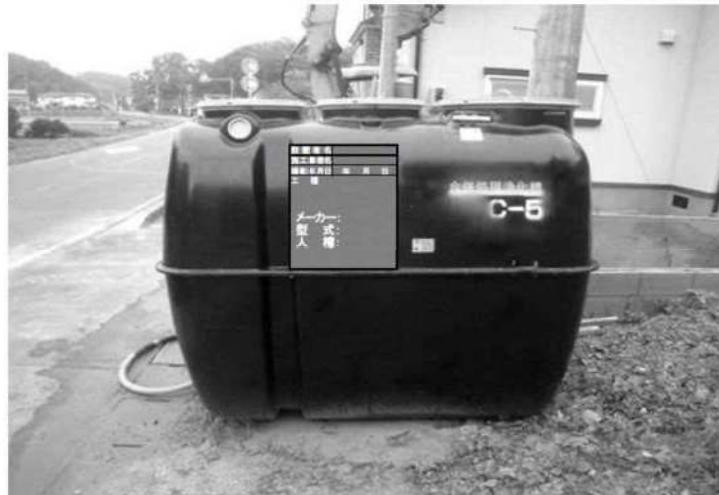
写真(浄化槽本体搬入の写真)
