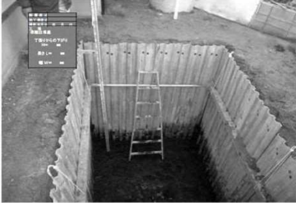
写真(床付け完了状況)
