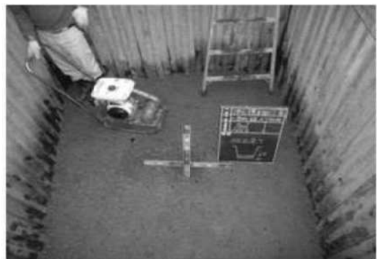
写真(基礎碎石仕上り状況 例2)
