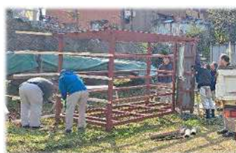
鉄筋の骨組みからスタート
