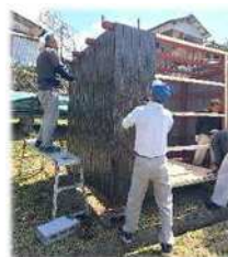
鉄板の壁を打ち付けて
