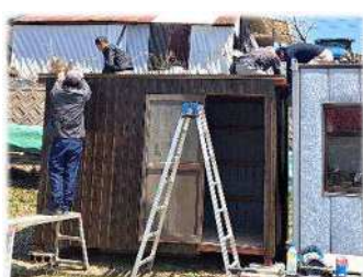
波板の屋根を取り付け
