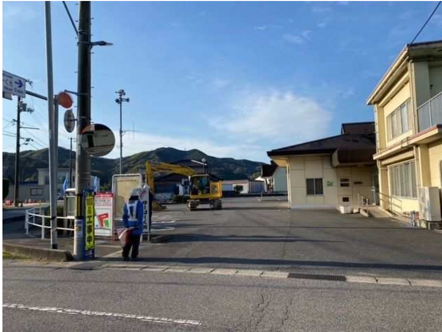
令和6年1月22日に着工しました。
