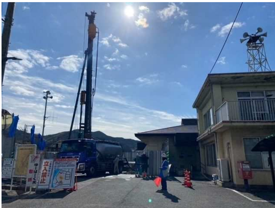
杭工事を行っています。
