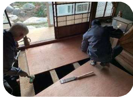
傷んでいた箇所の改修を実施
