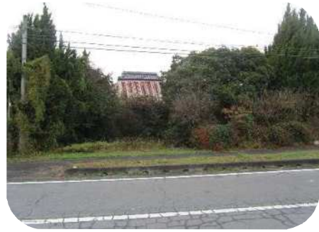
空き家を地域内外の交流施設とするために改修スタート
