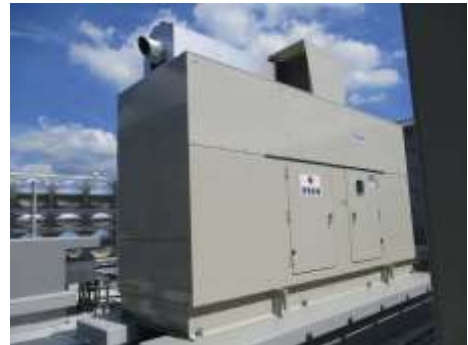
非常用発電機の屋上設置
