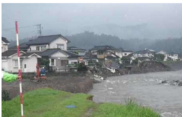
河岸侵食による家屋の倒壊(花月川)
