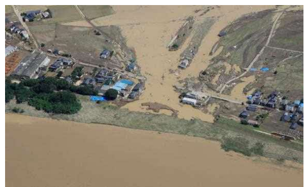
堤防決壊による家屋の流失(鬼怒川)
