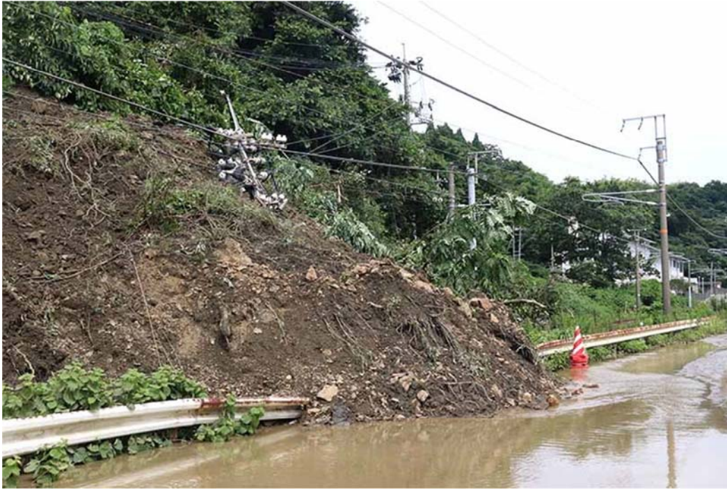
【浅江地区（JR山陽本線、国道 188 号）】
