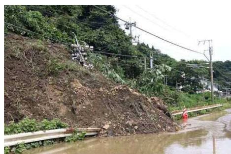
浅江地区 (JR山陽本線、国道188号)
