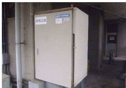
県防災行政無線非常用発電設備
