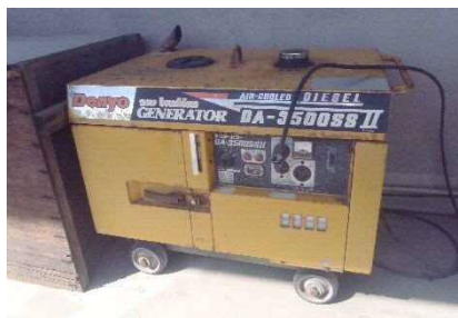
可搬式発電機（19台）
