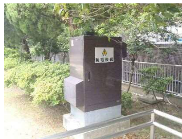
市防災行政無線非常用発電設備
