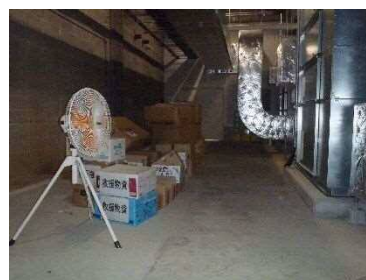
機械室の一部
