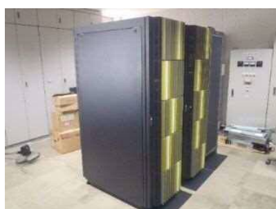
電算システムサーバー
