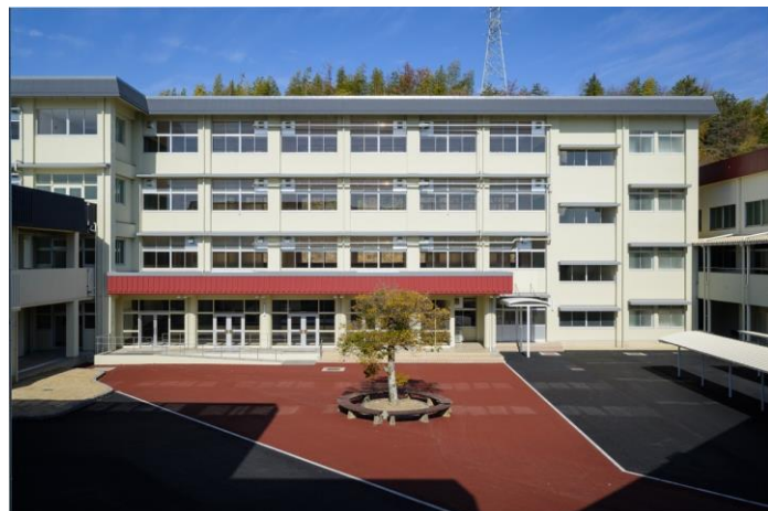
エントランス広場
