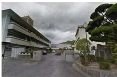
②からの現況写真
