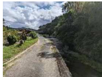
C 田布施川側道（川上側）
