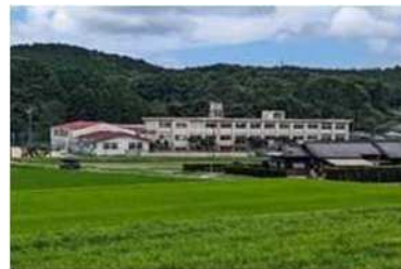
③からの現況写真
