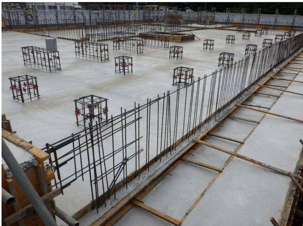
2階躯体（写真は屋上及び3階床部分）のコンクリート打設後の様子です。
