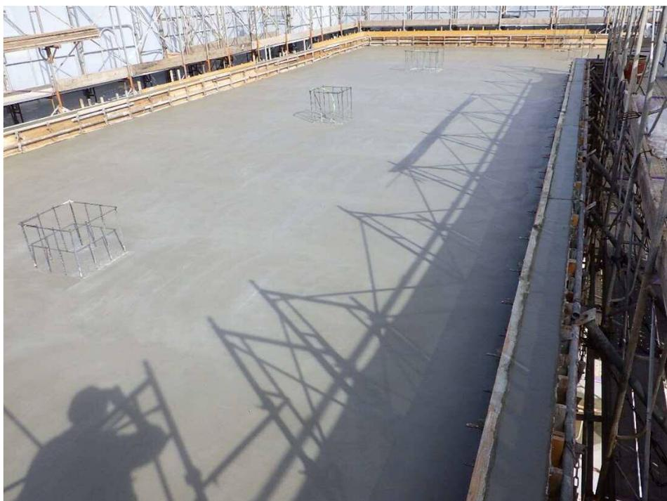
3階躯体（写真は3階の屋上部分）のコンクリート打設後の様子です。
