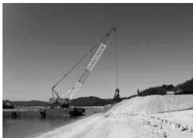
光漁港海岸保全施設整備事業
