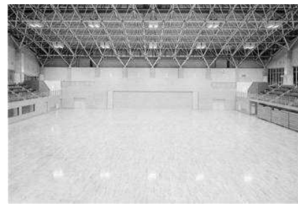
総合体育館空調設備更新
