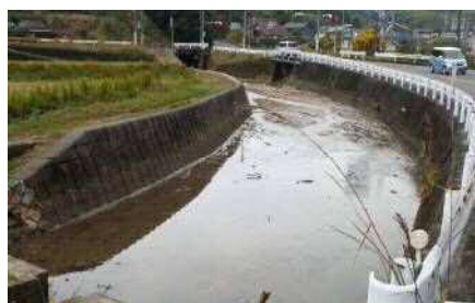
河川水路浚渫事業
