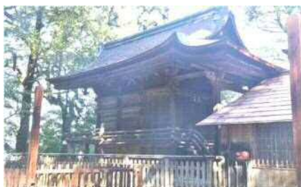
石城神社本殿保存修理事業
