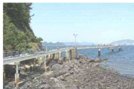
フィッシングパーク施設整備工事
