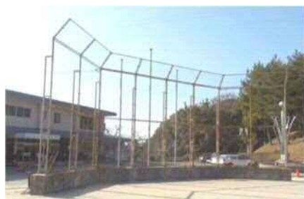
公園施設長寿命化計画策定事業
