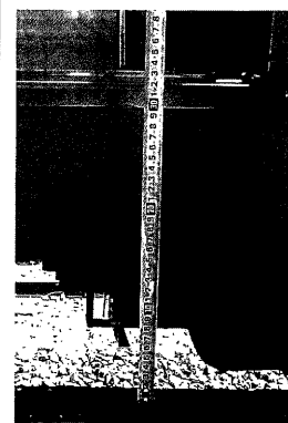
段差33センチの光駅上り線
