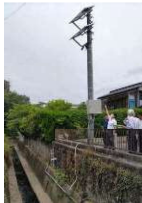
花園水路水門付近
