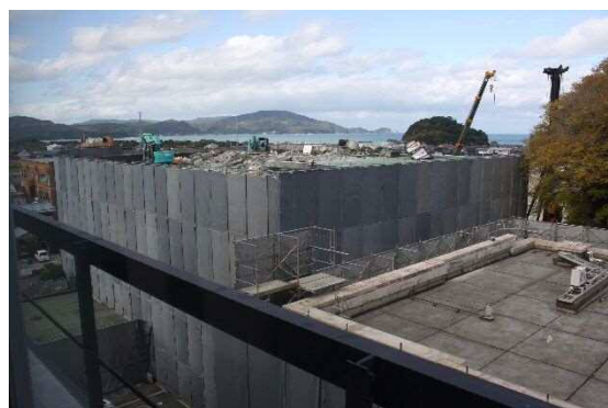
解体中の旧庁舎
