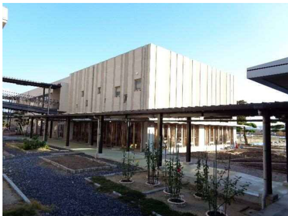
木を生かした小学校棟
