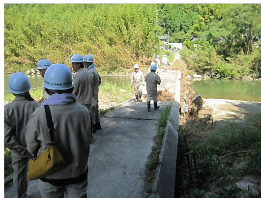
④小野橋周辺
