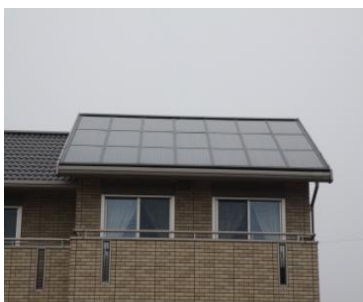
住宅用太陽光発電システム
