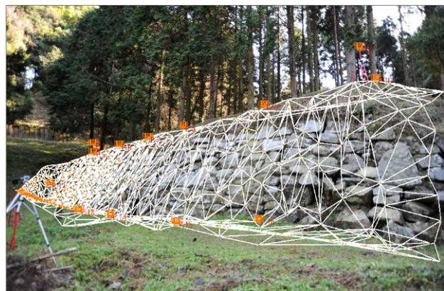
図24 レーザープロファイラー測量結果から作成した不整三角形網を撮影写真に重ね合わせた結果
