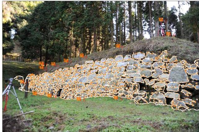
図28 積石の縁のベクトル化処理の結果と写真画像の合成
