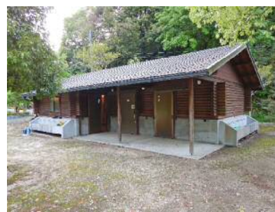
周防の森ロッジ施設機能強化事業
