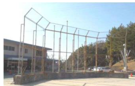
公園施設長寿命化計画策定事業
