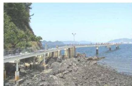
フィッシングパーク施設整備工事
