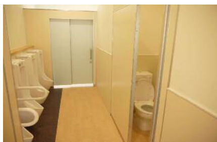
小中学校トイレ改修工事
