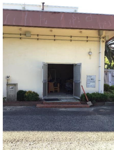
機械室搬出口
