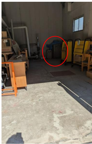
機械室内（右手奥にP C B廃棄物）
