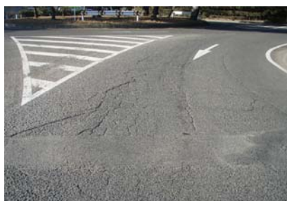
◆市内市道舗装改良
