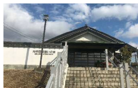
憩いの家トイレ改修工事
