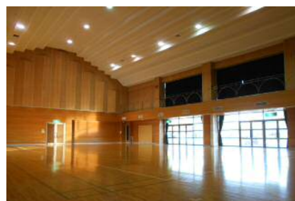
公共施設におけるLED照明の導入
