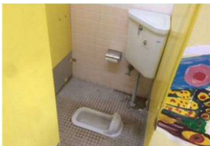
公立幼稚園施設整備
