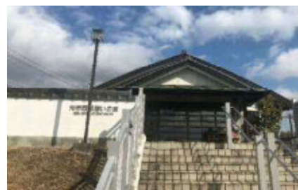
憩いの家トイレ改修工事
