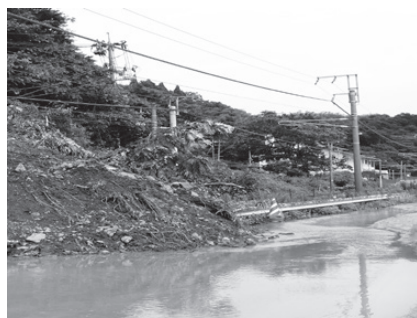
▲平成30年7月豪雨による甚大な被害(浅江懸山)
