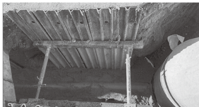
下水道事業 管渠布設工事
