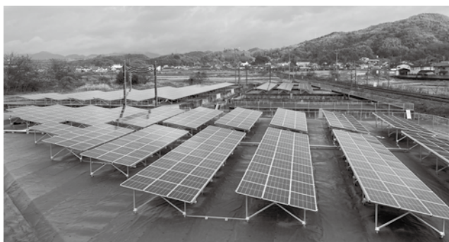
水道事業 太陽光発電設備設置工事
