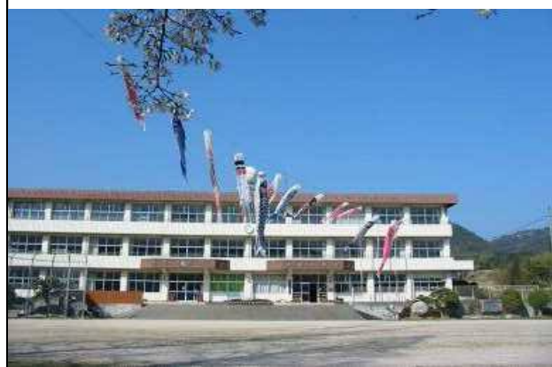
校舎等の外観写真
