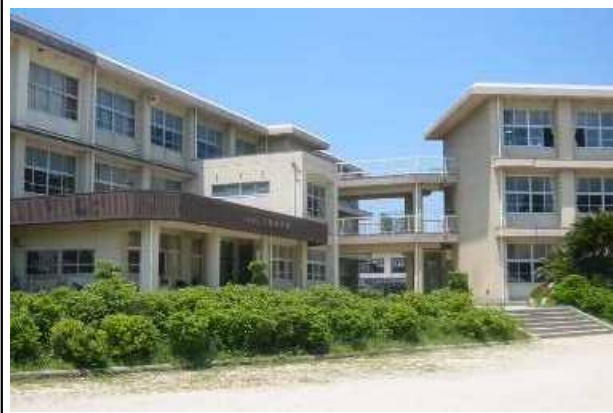
校舎等の外観写真
