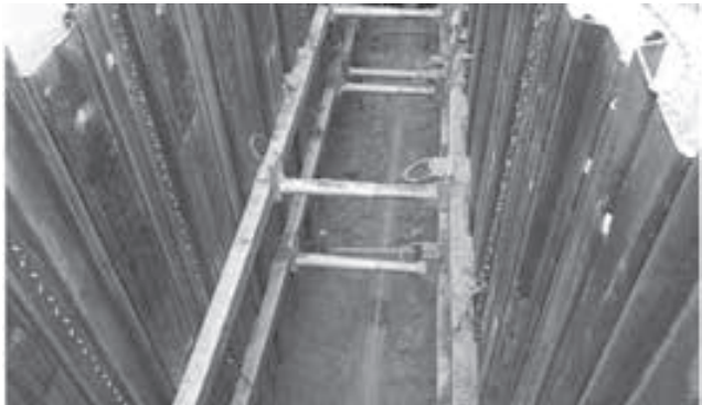
下水道事業 管渠布設工事
