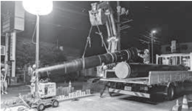
水道事業 清山送水管布設替工事（第2工区）
