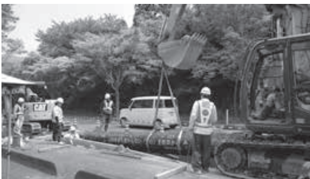
▲水道事業 タイム送水管の埋設工事
