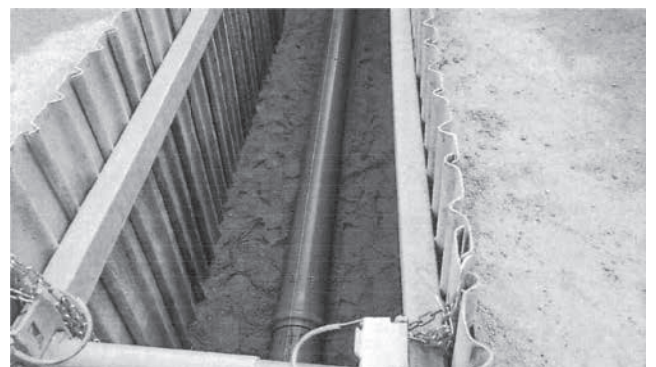
▲下水道事業 下水道管の布設替工事
